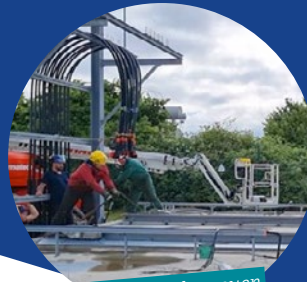
Einbringen des neuen Transformators
