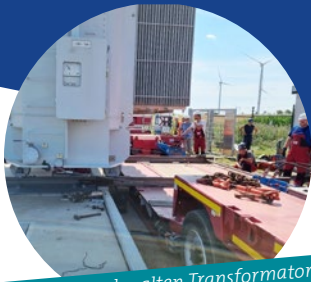
Ausbringen des alten Transformators per Schienensystem
