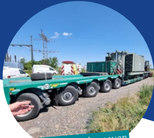
Anlieferung des neuen Transformators
