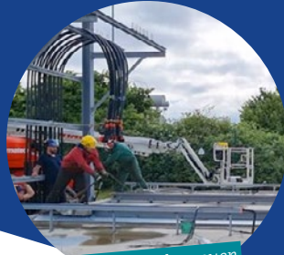
Einbringen des neuen Transformators
