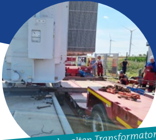
Ausbringen des alten Transformators per Schienensystem
