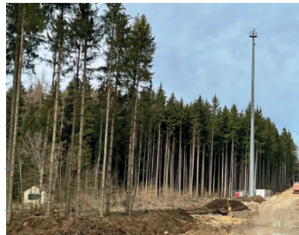
Windpark-Baustelle im Wald mit „IdentiFlight“-Mast
