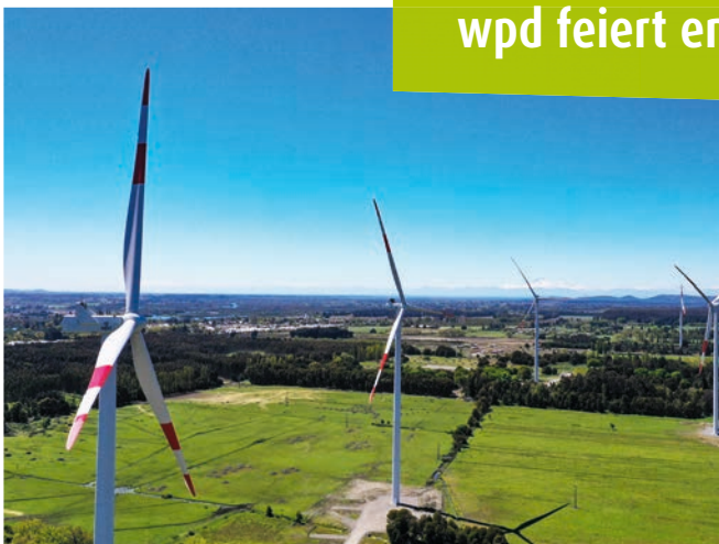
Windenergieanlagen des Windparks Negrete kurz vor der Inbetriebnahme
