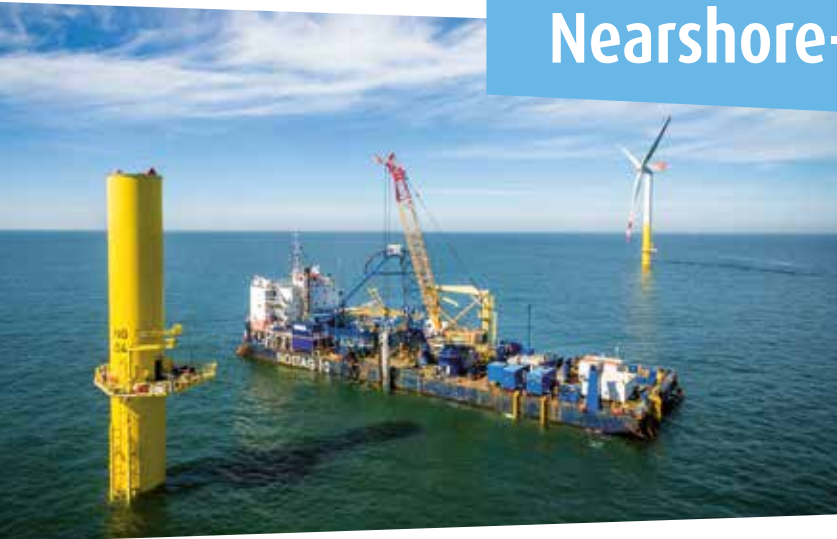
Kabelinstallation im Baufeld Nordergründe
