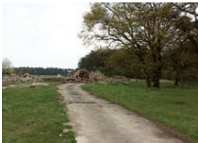
Während der Abbruchmaßnahmen
