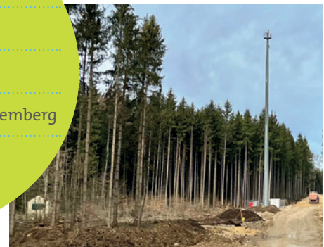
Windpark-Baustelle im Wald mit „IdentiFlight“-Mast
