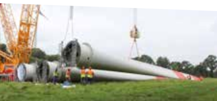
Rotorblatt-Montage im Windpark Hambergen
