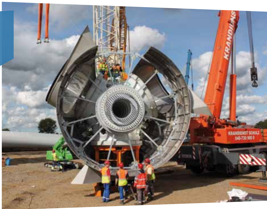
Aufbauarbeiten von acht Enercon E-101 im Windpark Alt Bennebek in Schleswig-Holstein
