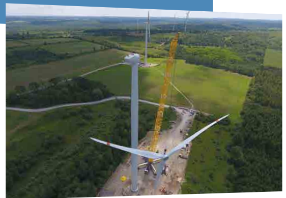
wpd Windpark Sumac Ridge beim Abschluss der Turbinen- installation Ende 2017.
