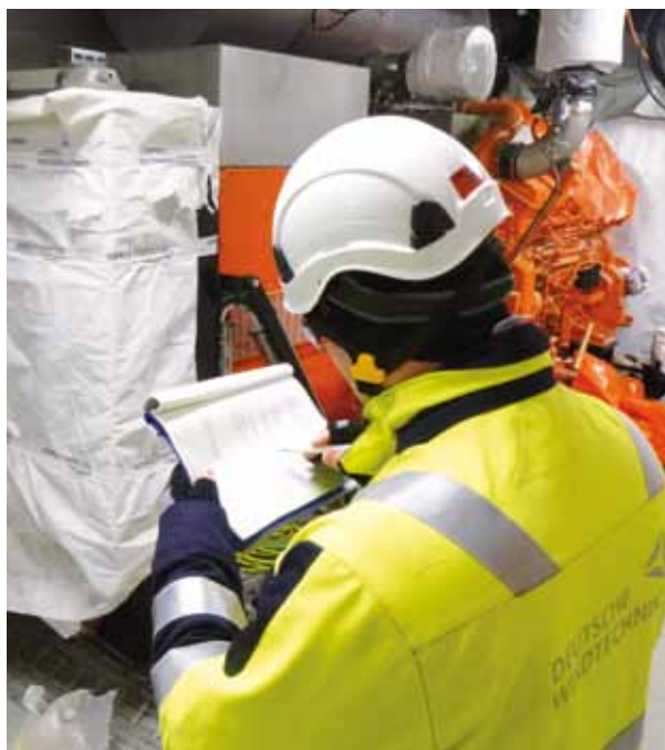
Fertigungsüberwachung des Umspannwerkes Butendiek: Check der Einzelsysteme nach Errichtungs- und Konstruktionsplan
