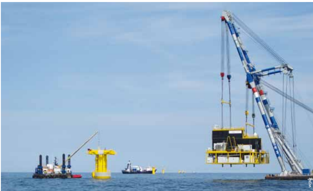
Bau des Offshore-Windparks Baltic 1 in der Ostsee
