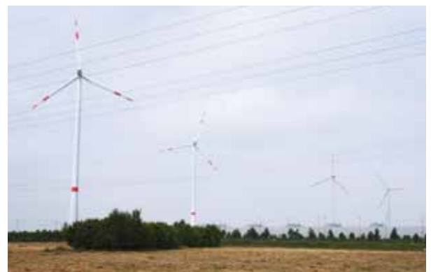
Die vier fertig errichteten Windenergieanlagen Mitte Juli
