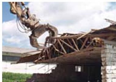
Abbrucharbeiten und Entsiegelung eines baufälligen Stallgebäudes
