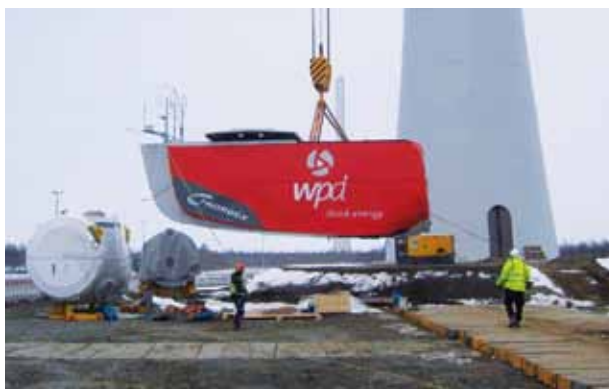
Gondelmontage der Nordex-Anlagen bei Winterwetter
