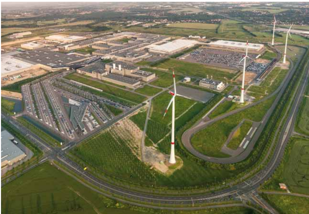
Der 10 Megawatt-Windpark in Leipzig auf dem BMW Werksgelände (Foto: BMW/Christoph Busse)
